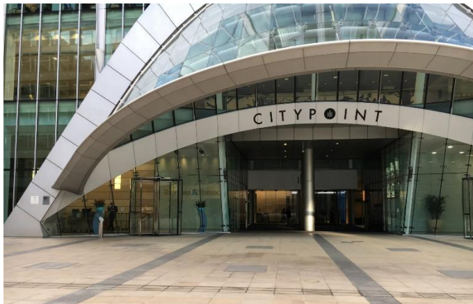
Locaux du cabinet Simmons & Simmons à Londres
